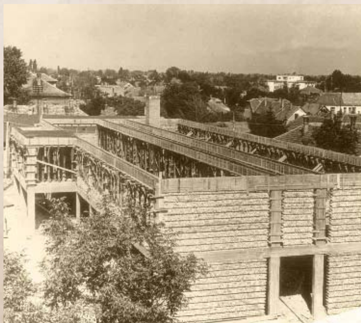
A KTSZ Szolgáltatóházának építése 1971-ben (PSVK HGY)
