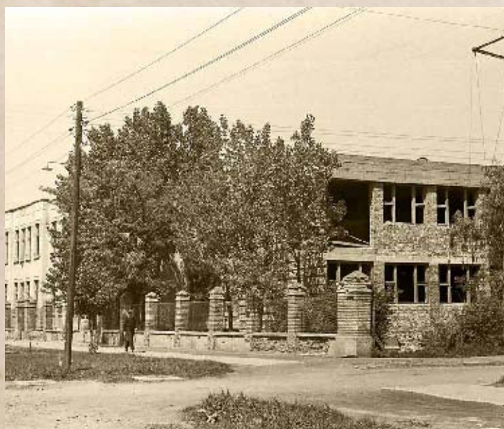
A Petőfi Sándor Gimnázium új épületszárnyának építése (PSVK HGY)
